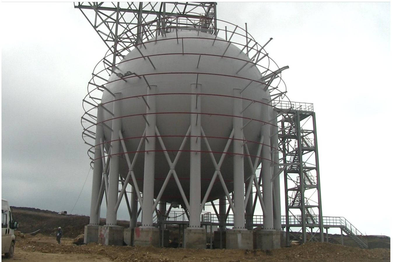
Рисунок 1 - Общий вид резервуаров
