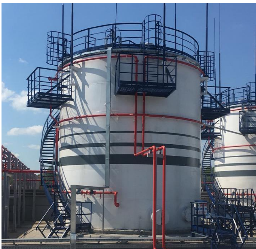
Рисунок 3 – Общий вид резервуара вертикального стального цилиндрического РВСП-500
