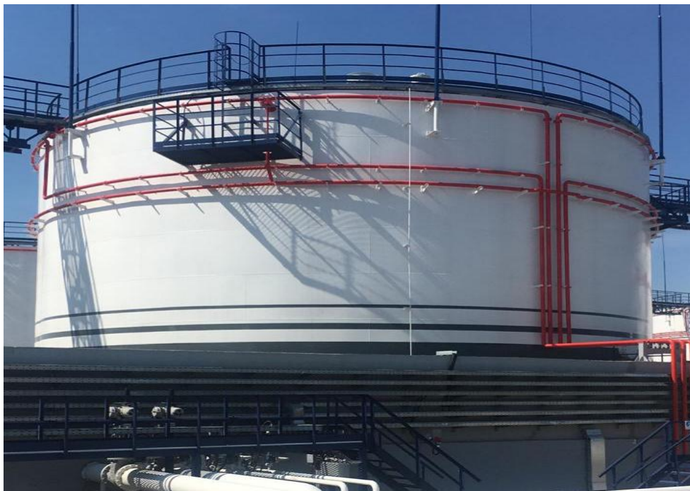
Рисунок 2 – Общий вид резервуара вертикального стального цилиндрического РВСП-3000
