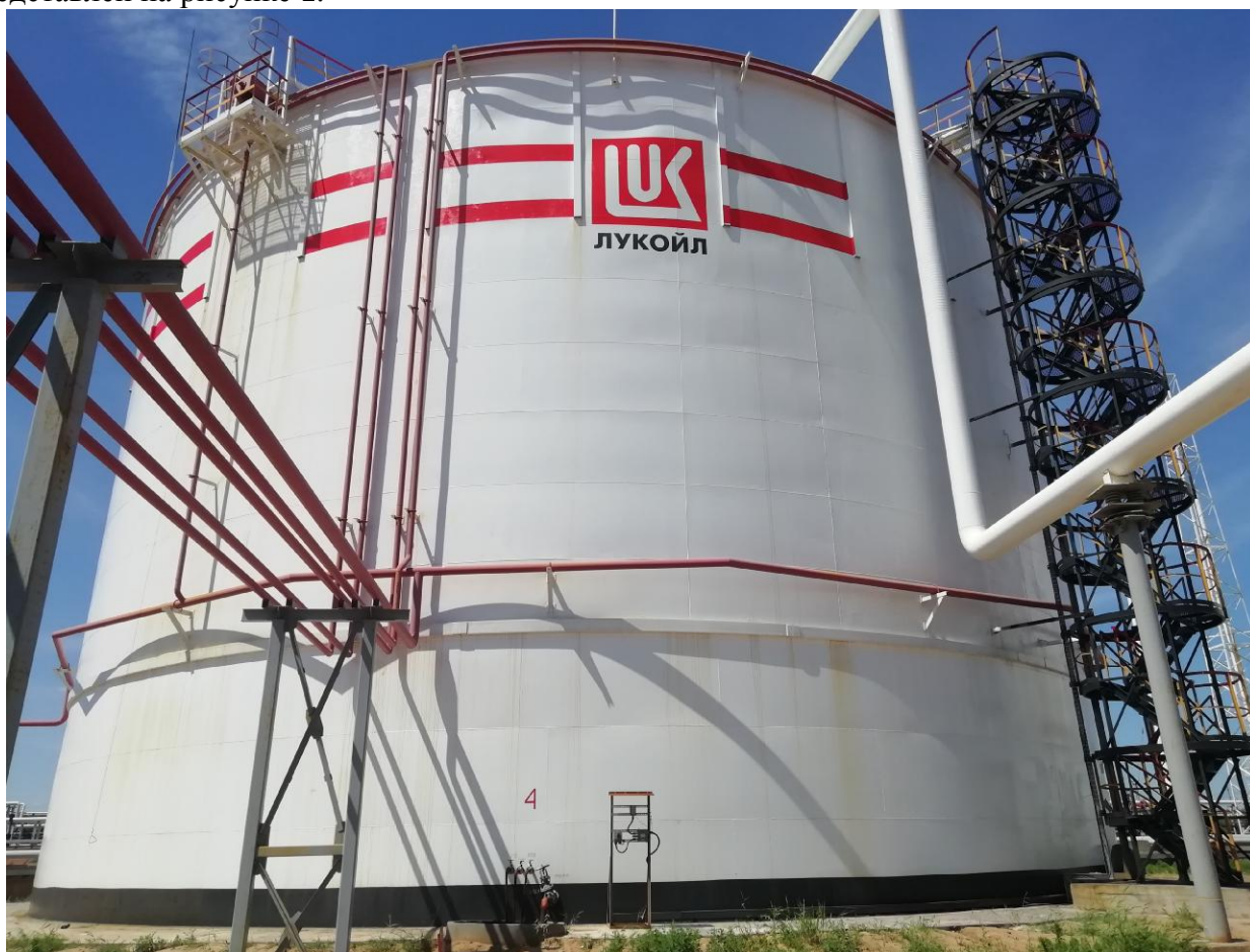
Рисунок 1 – Общий вид резервуара РВС-10000
