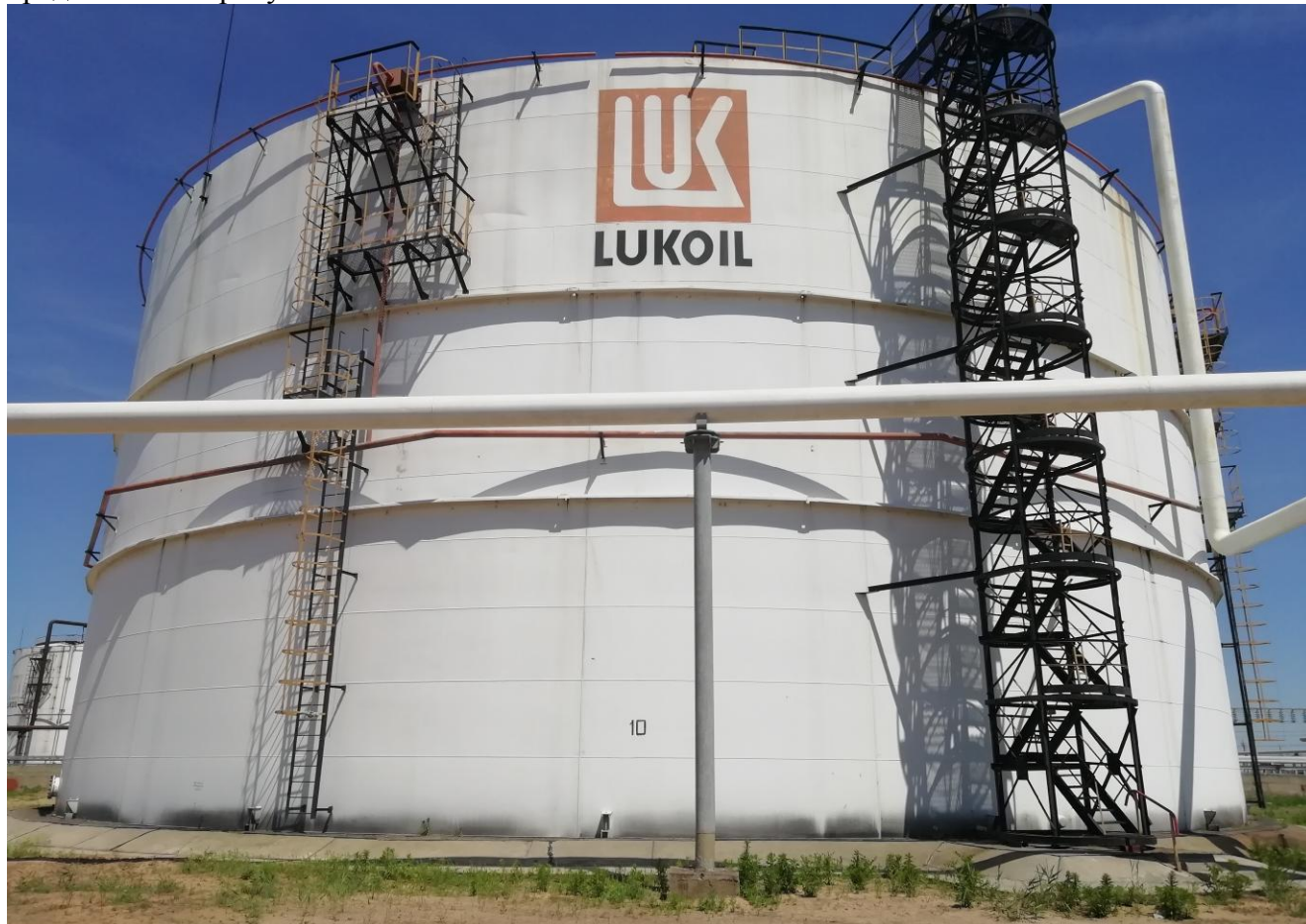
Рисунок 1 – Общий вид резервуара РВС-20000
