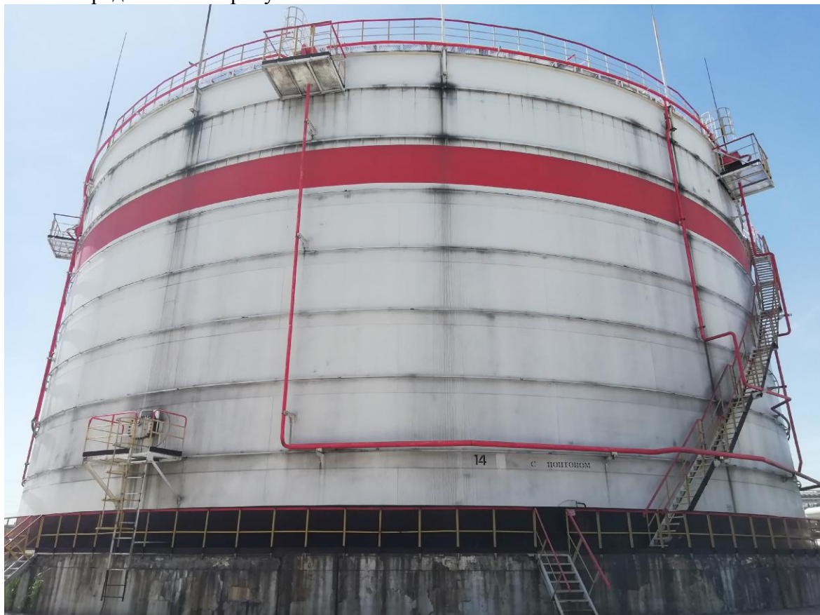
Рисунок 1 – Общий вид резервуара РВСП-20000
