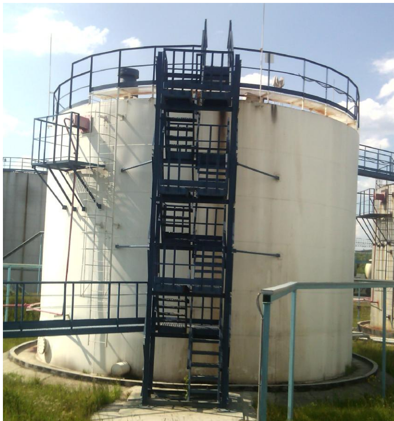
Рисунок 1 – Общий вид резервуара вертикального стального цилиндрического РВС-1000
