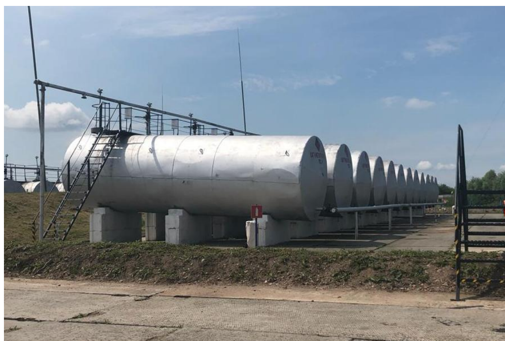
Рисунок 3 – Общий вид резервуаров РГС-50
