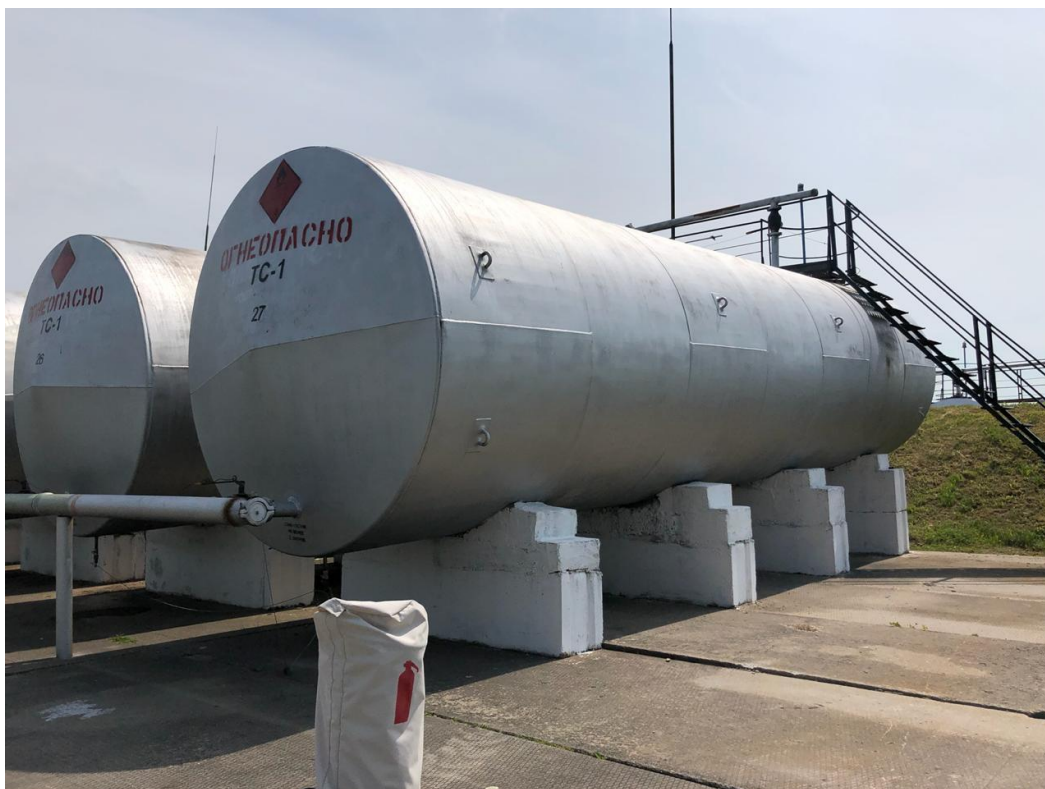
Рисунок 4 – Общий вид резервуаров РГС-60
