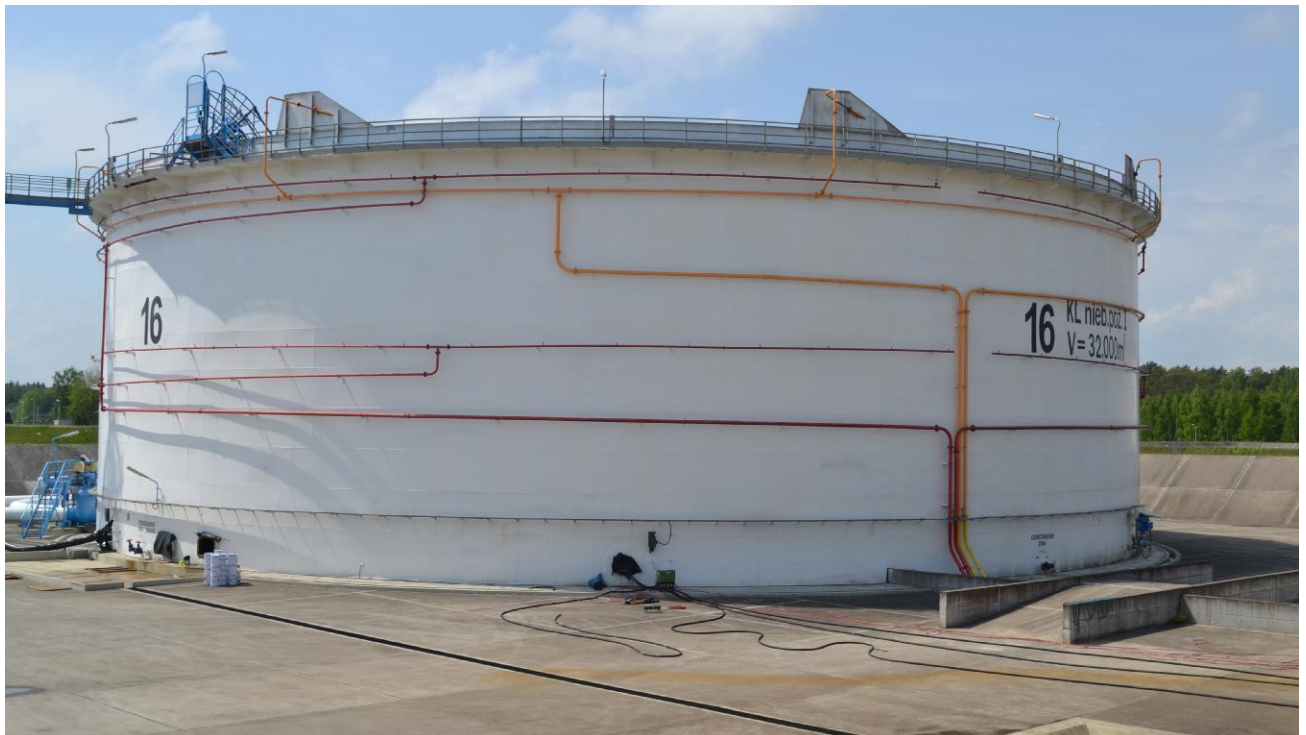
Рисунок 1 – Общий вид резервуара РВСПК-32000
