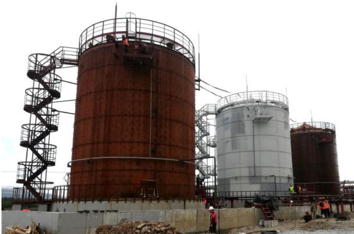
Рисунок 1 - Общий вид резервуаров
