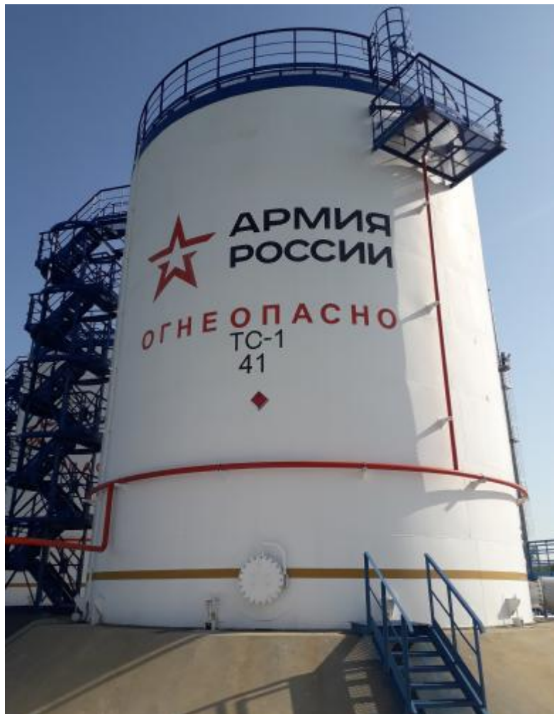
Рисунок 1 – Общий вид резервуара РВС-1000
