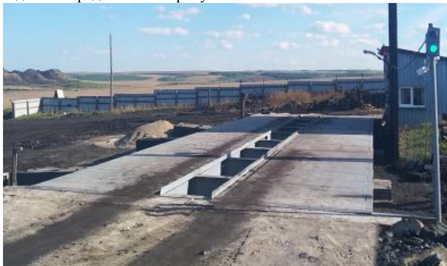
Рисунок 1 - Общий вид весов ВТСА 120
