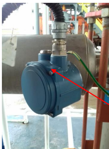
Схема пломбировки преобразователя счетчика-расходомера массового
