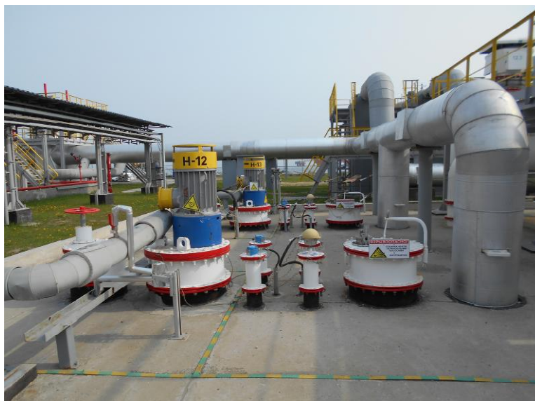
Рисунок 2 - Общий вид площадки размещения резервуара РГС-100 № 778
