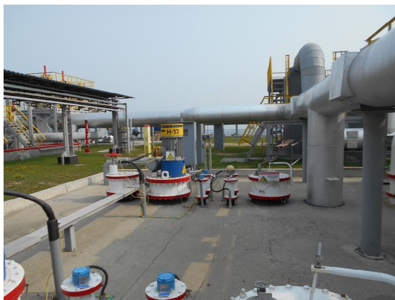
Рисунок 3 - Общий вид площадки размещения резервуара РГС-100 № 779
