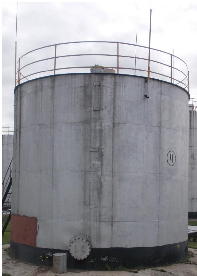
Рисунок 1 - Общий вид резервуара стального вертикального цилиндрического РВС-200
