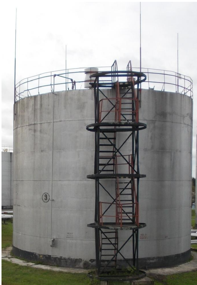
Рисунок 2 - Общий вид резервуара стального вертикального цилиндрического РВС-700
