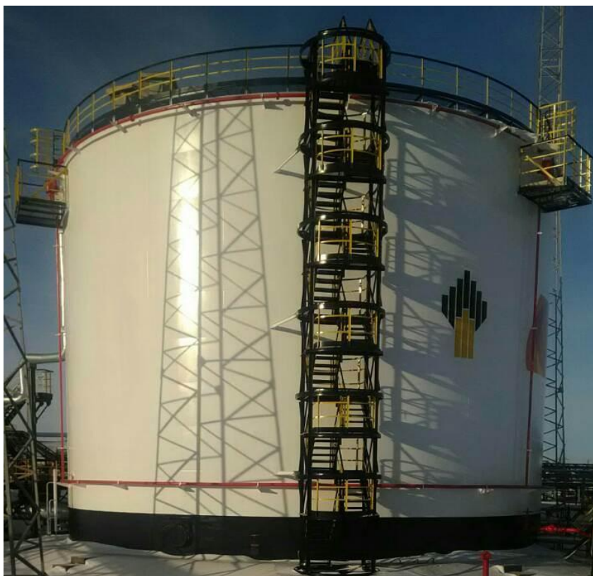
Рисунок 1 - Общий вид резервуара стального вертикального цилиндрического РВС-5000
