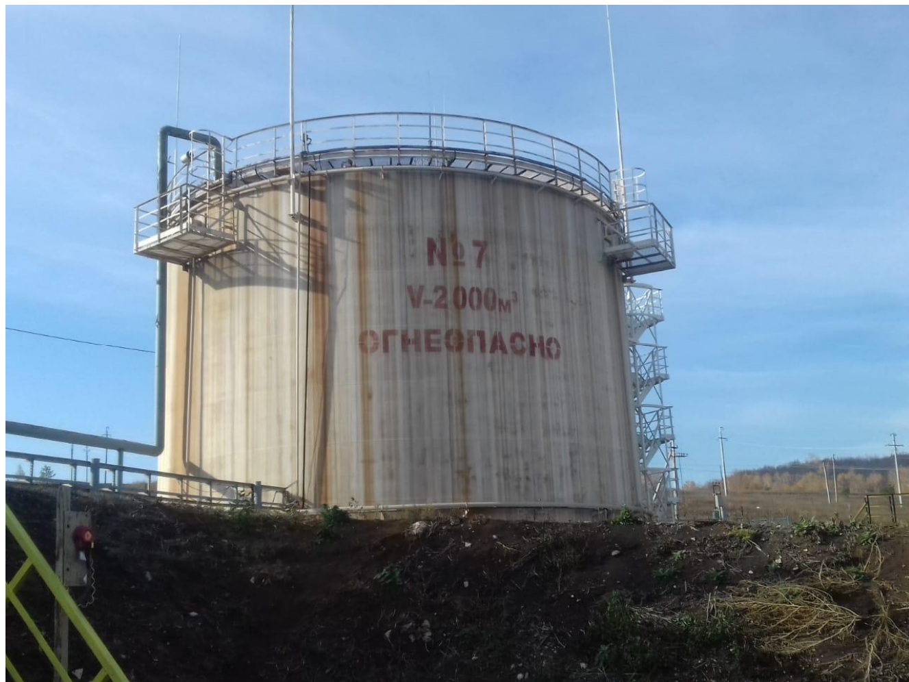
Рисунок 1 - Общий вид резервуара РВС-2000
