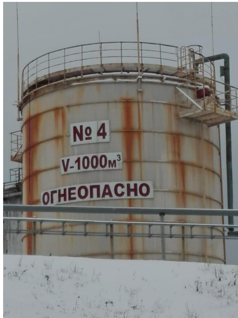
Рисунок 1 - Общий вид резервуара РВС-1000
