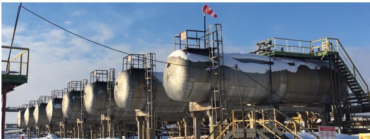
Рисунок 1 - Общий вид резервуара стального горизонтального цилиндрического РГС-100
