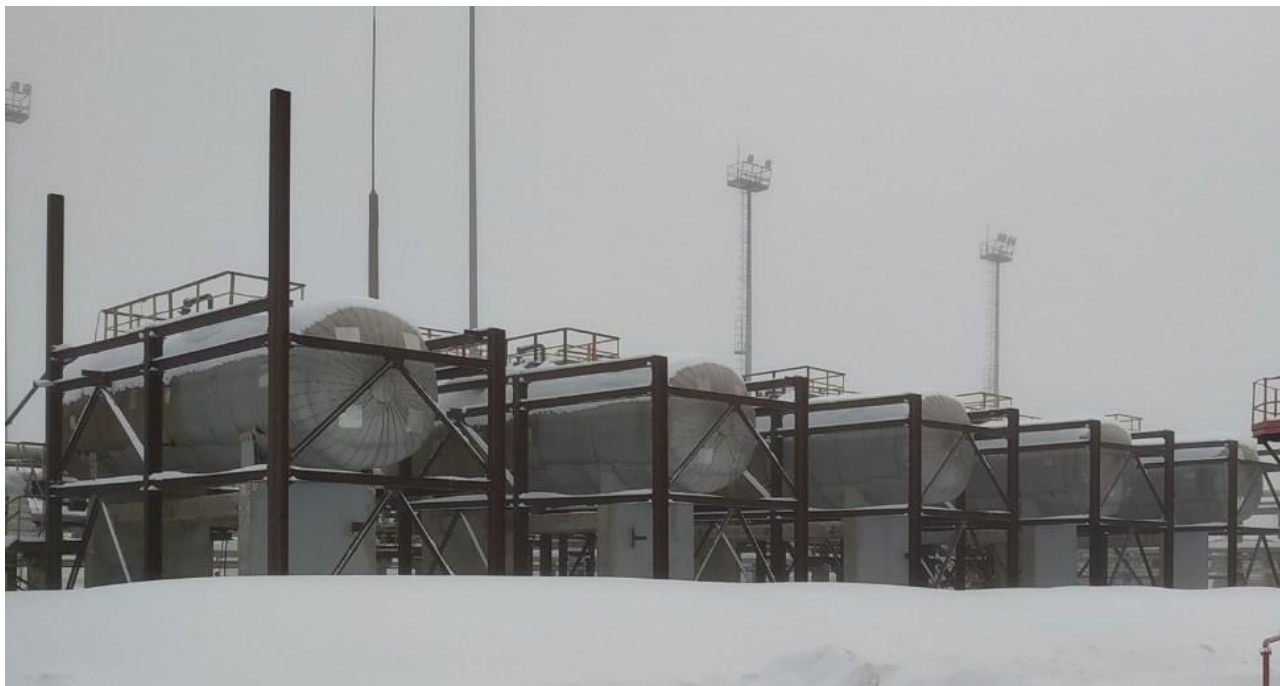
Рисунок 1 - Общий вид резервуара стального горизонтального цилиндрического РГС-90
