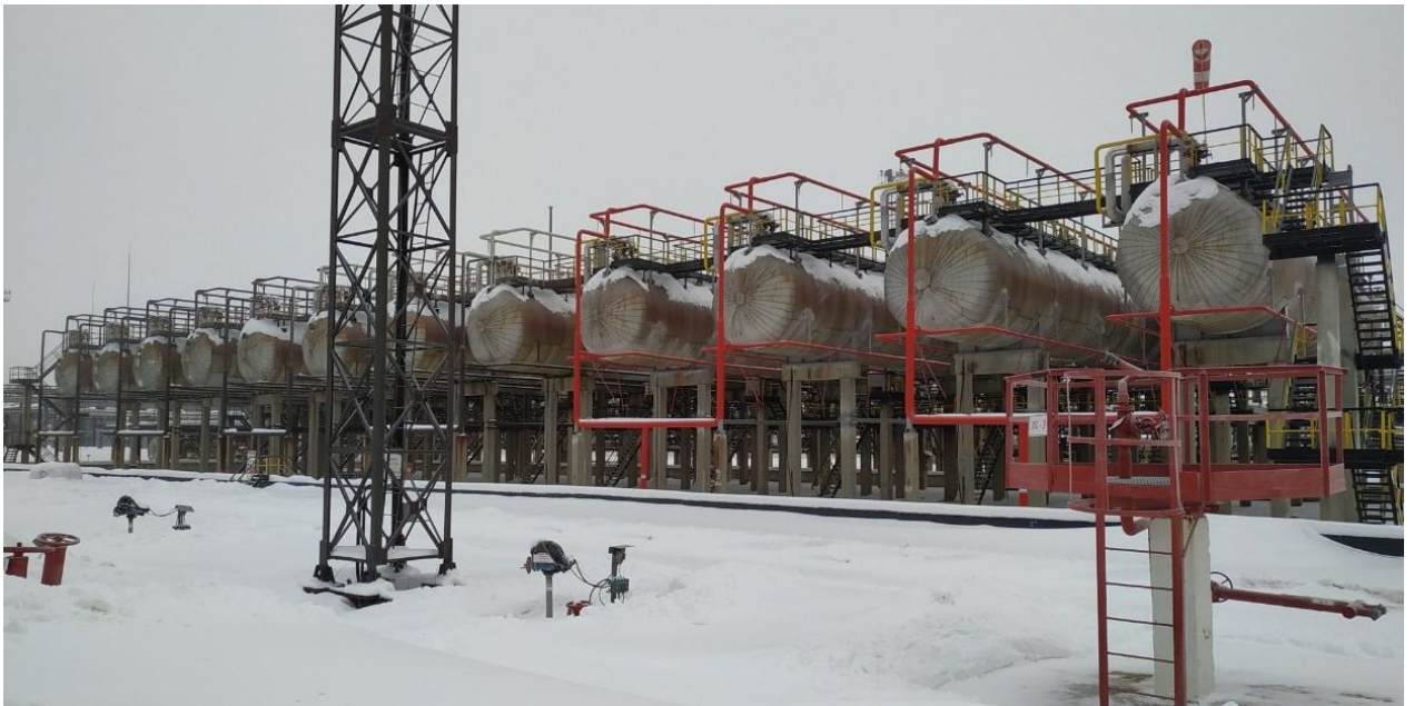
Рисунок 1 - Общий вид резервуара стального горизонтального цилиндрического РГС-200
