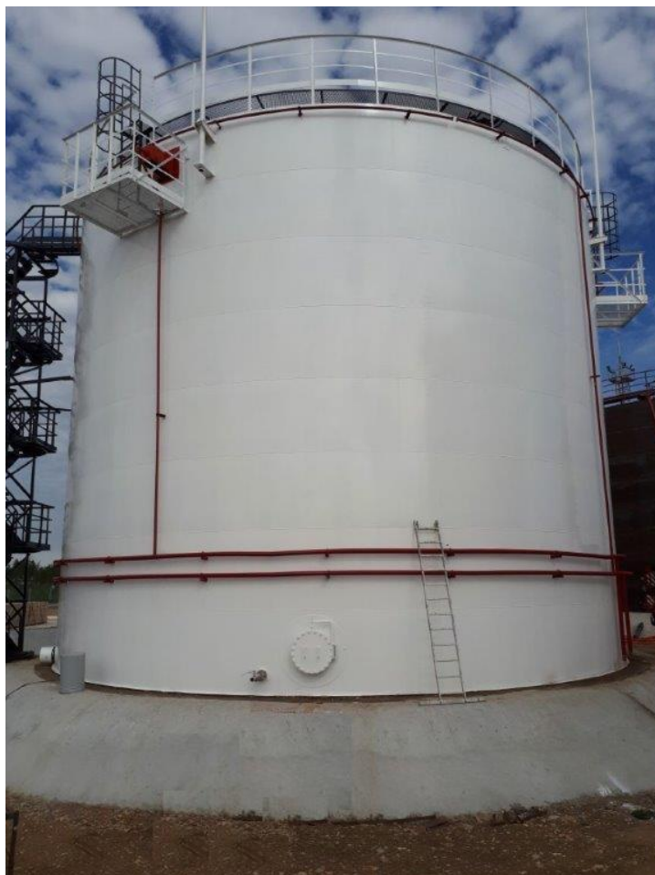
Рисунок 1 - Общий вид резервуара РВС-2000
