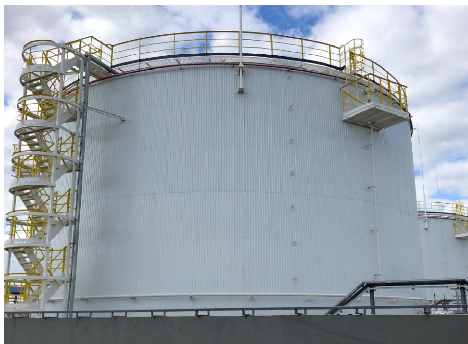
Рисунок 1 - Общий вид резервуаров стальных вертикальных цилиндрических РВС-5000
