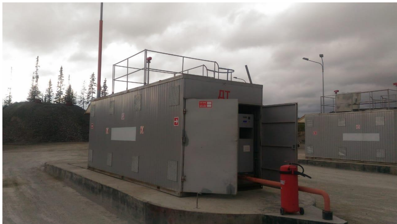
Рисунок 1 - Общий вид резервуара РГС-20
