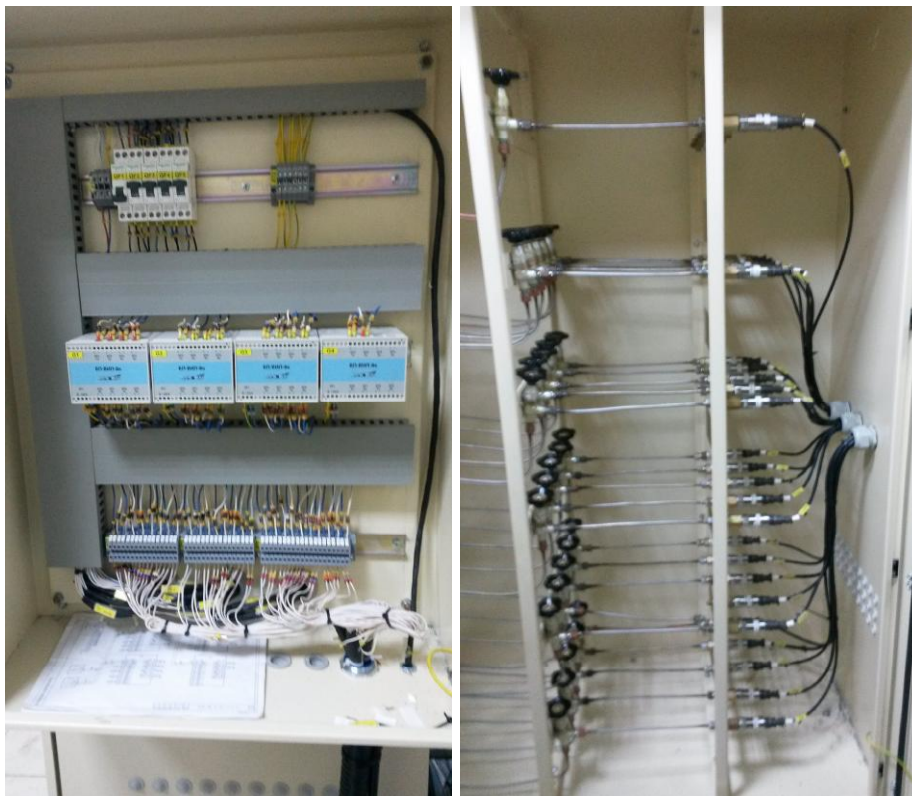
Рисунок 5 - Шкаф измерения давлений, расположенный в пультовой. Расположение элементов.
