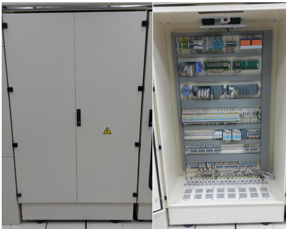
Рисунок 2 - Стойка АИИС. Расположение элементов. Вид внешний
