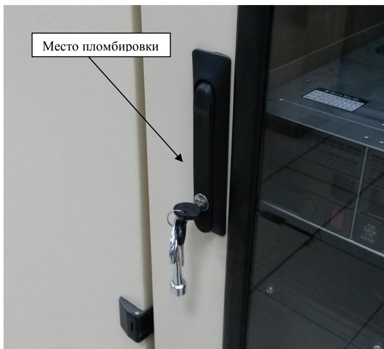
Рисунок 6 - Место пломбировки от несанкционированного доступа
