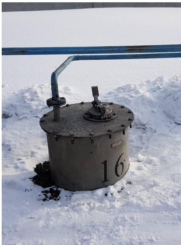
Рисунок 6 - Общий вид видимой части конструкции резервуаров РГС-75 зав. №№ 16, 17
