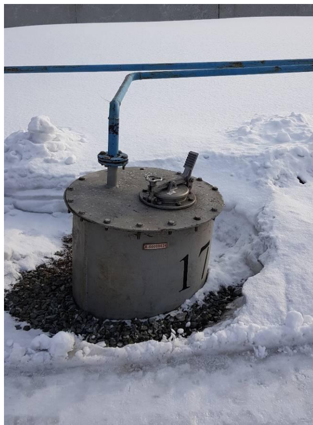
Рисунок 6 - Общий вид видимой части конструкции резервуаров РГС-75 зав. №№ 16, 17
