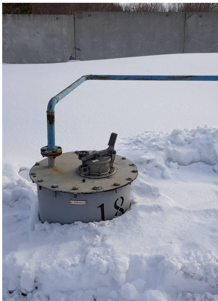
Рисунок 7 - Общий вид видимой части конструкции резервуара РГС-75 зав. № 18
