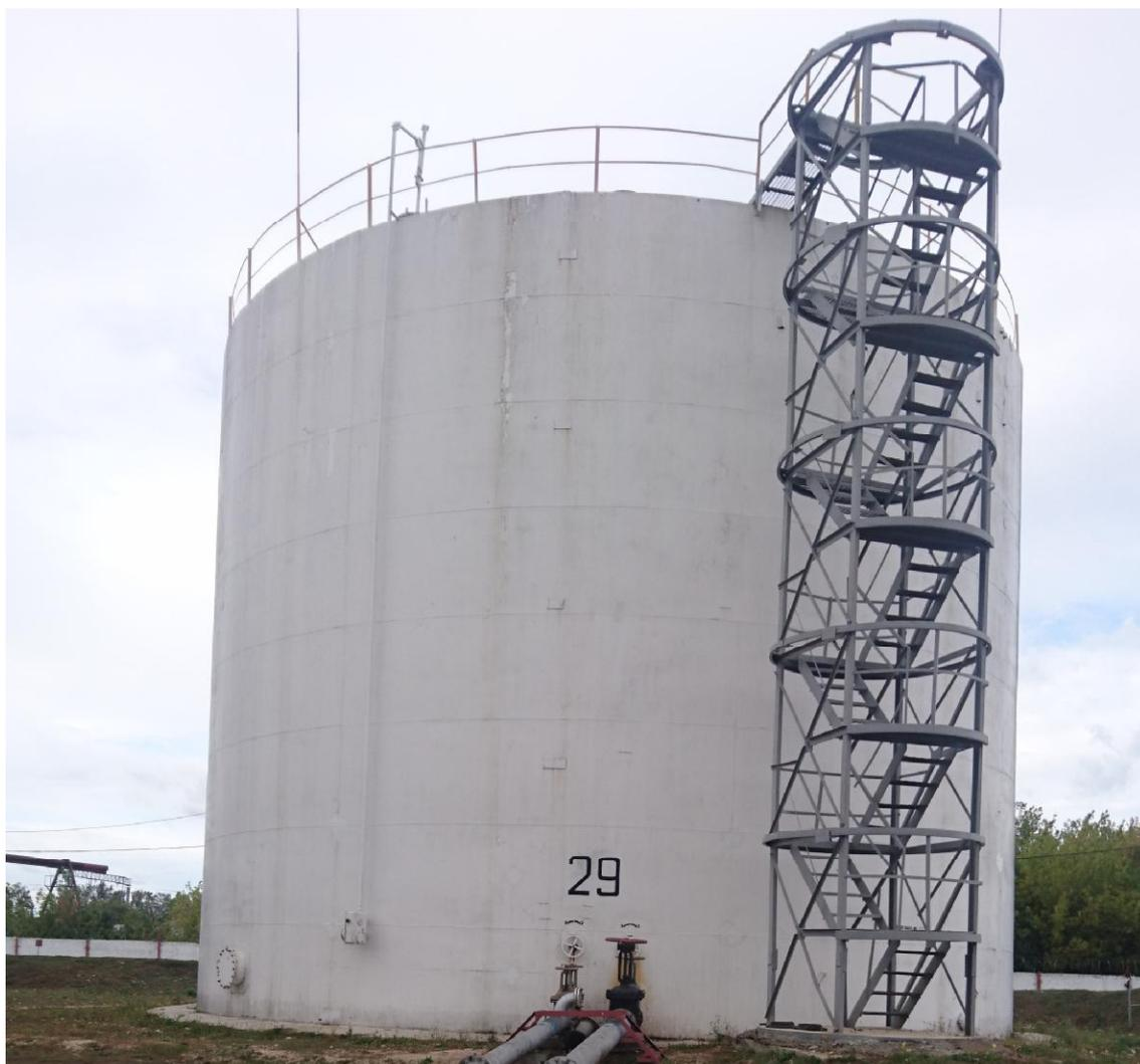
Рисунок 1 - Общий вид резервуара стального вертикального цилиндрического РВС-2000
