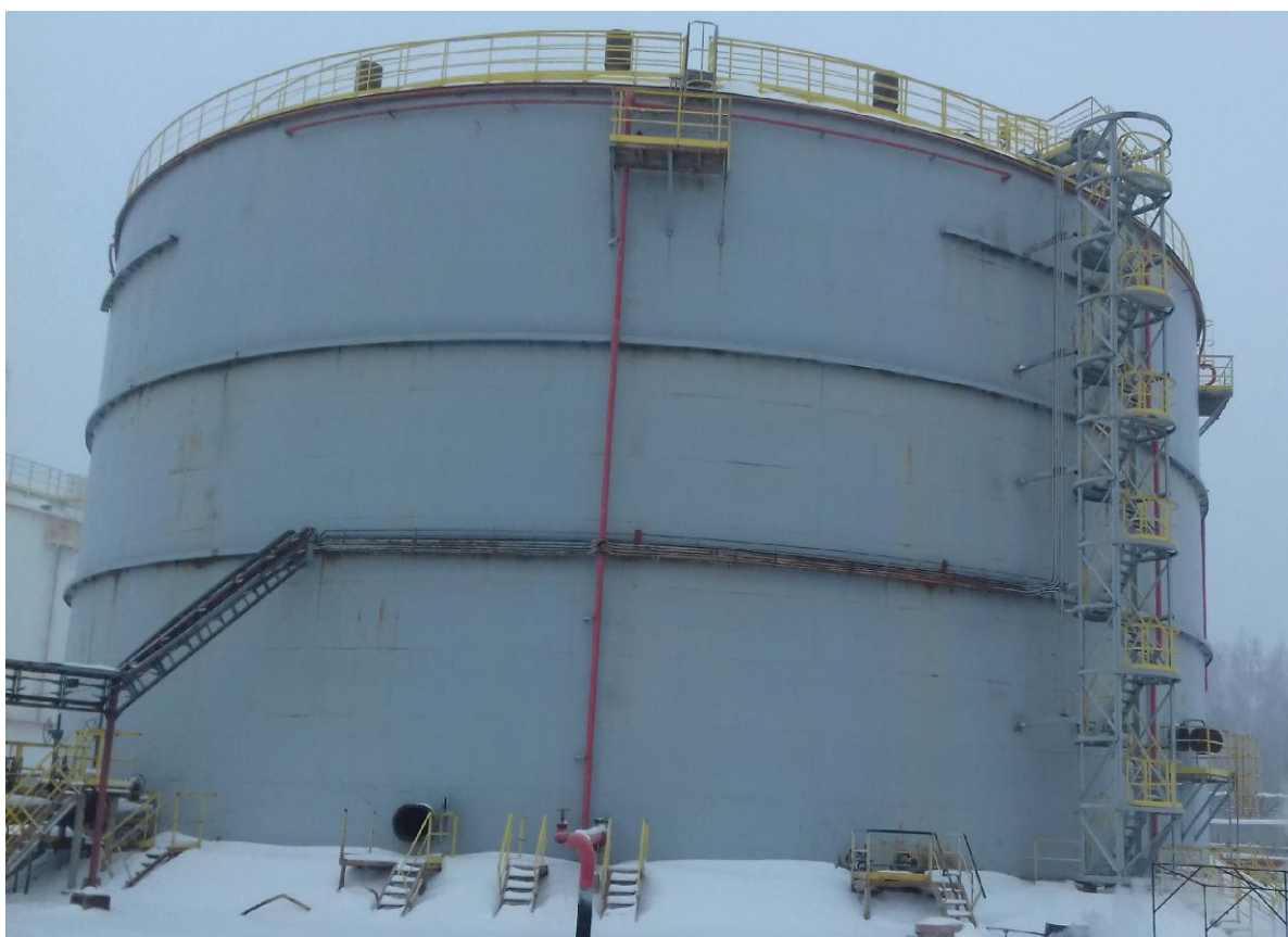
Рисунок 1 - Общий вид резервуара стального вертикального цилиндрического РВСП-20000
