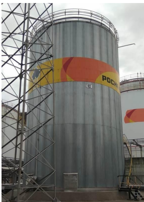
Рисунок 1 - Общий вид резервуара РВС-2000
