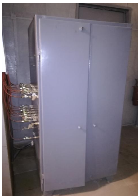
Рисунок 2 - Шкаф датчиков давления (ШкДД)
