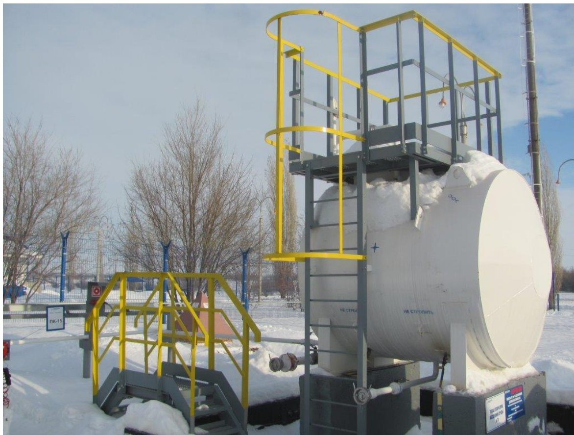
Рисунок 1 - Общий вид резервуара РГС-5 № 40
