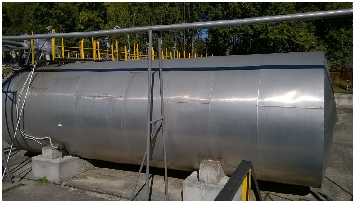
Рисунок 1 - Общий вид резервуара стального горизонтального цилиндрического РГС-50
