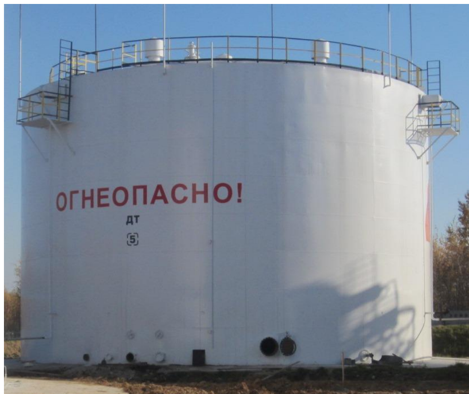
Рисунок 2 - Общий вид резервуара стального вертикального цилиндрического РВС-3000
