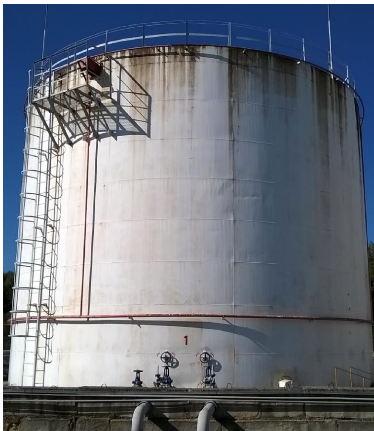
Рисунок 2 - Общий вид резервуара стального вертикального цилиндрического РВС-2000
