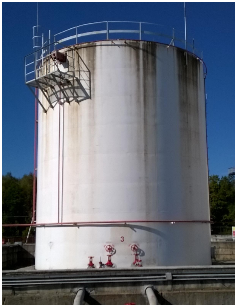
Рисунок 1 - Общий вид резервуара стального вертикального цилиндрического РВС-1000
