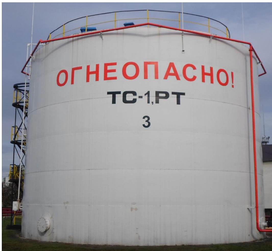
Рисунок 1 - Общий вид резервуара стального вертикального цилиндрического РВС-1000
