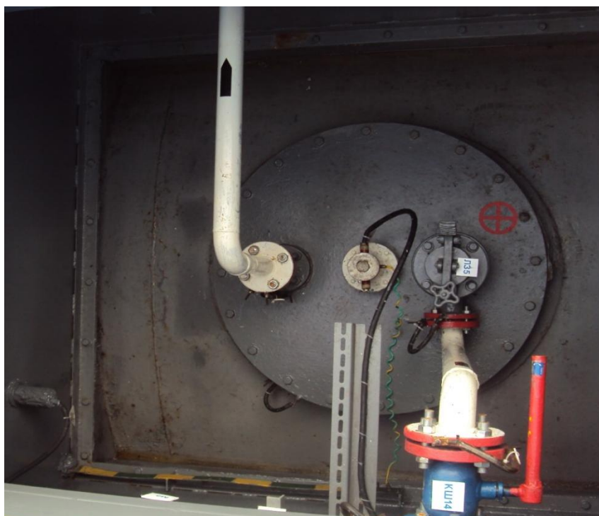
Рисунок 1 - Общий вид видимой части конструкции резервуара РГСО-25 № 0086.3
