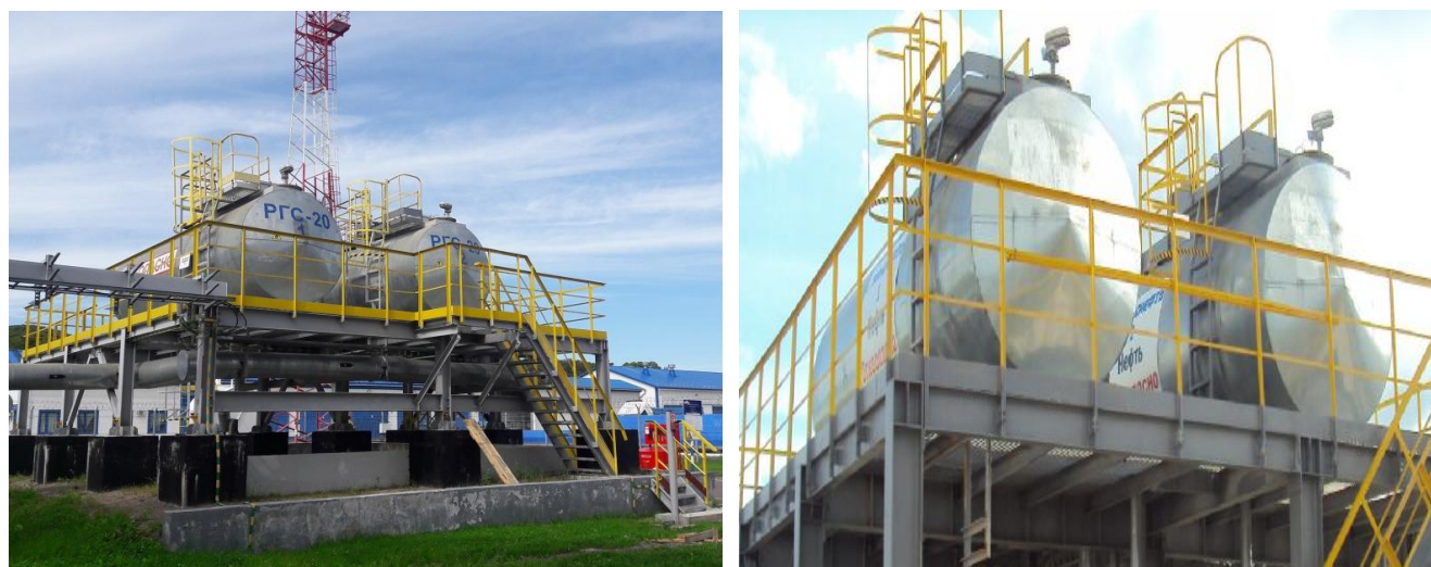
Рисунок 2 - Общий вид резервуаров РГС-20 №№ 191, 192 (слева), №№ 199, 200 (справа)
