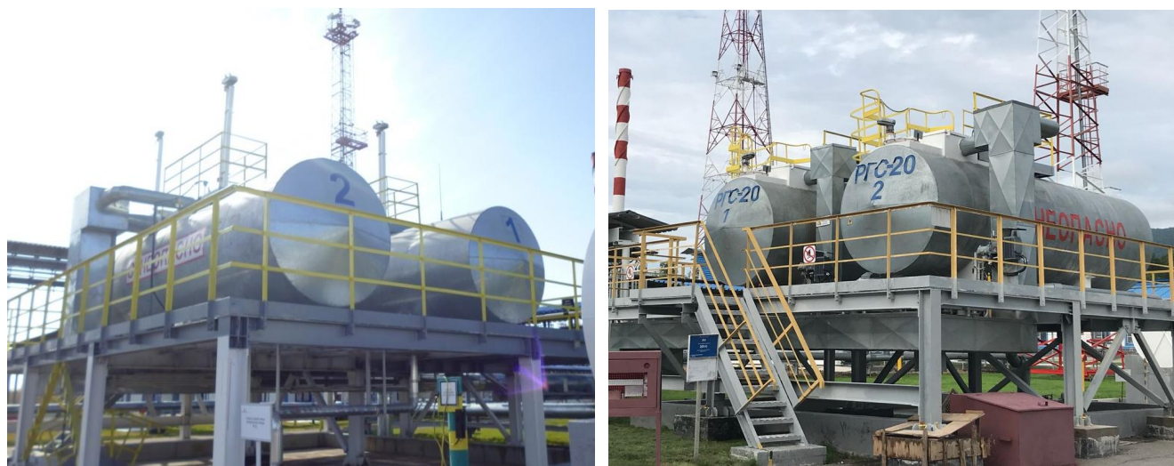
Рисунок 1 - Общий вид резервуаров РГС-20 №№ 183, 184 (слева), №№ 185, 186 (справа)
