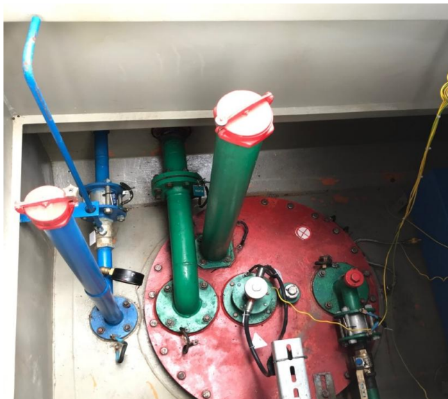
Рисунок 3 - Общий вид видимой части конструкции резервуаров РГС-25 № 1/25-А (слева), РГСД-50 № 3/50-2БХТ (справа)
