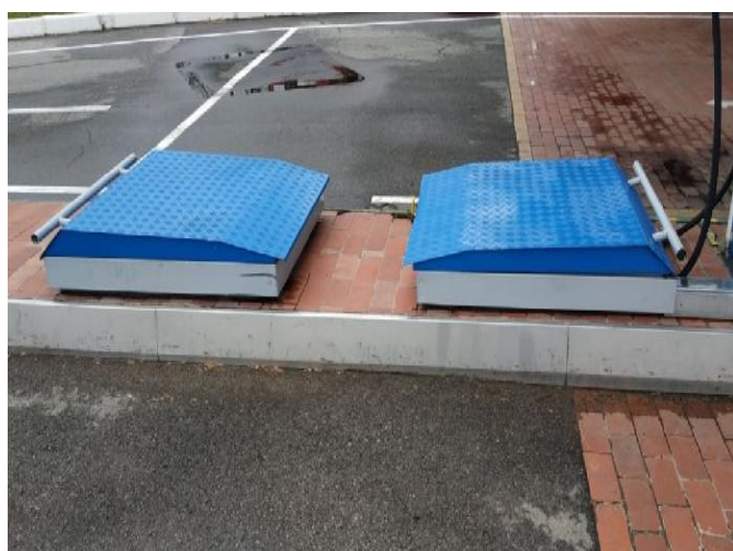
Рисунок 8 - Общий вид видимой части конструкции резервуара РГСД-50 № 4/50-2БХТ
