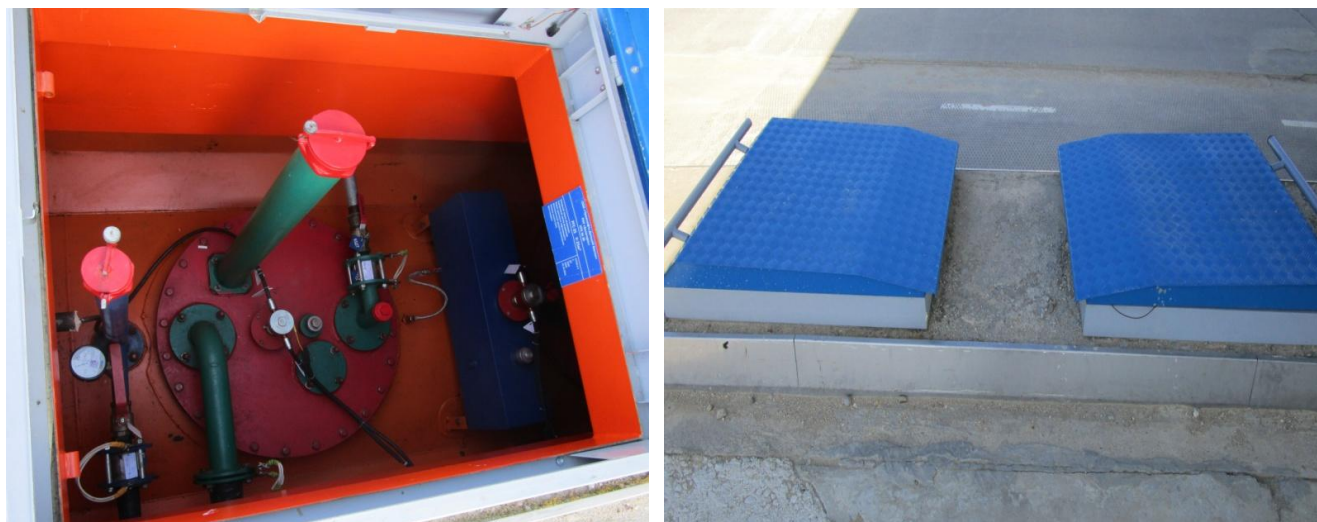
Рисунок 12 - Общий вид видимой части конструкции резервуаров РГСД-50 №№ 26/50-2БХТ, 27/50-2БХТ
