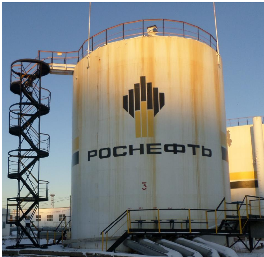
Рисунок 1 - Общий вид резервуара стального вертикального цилиндрического РВС-1000
