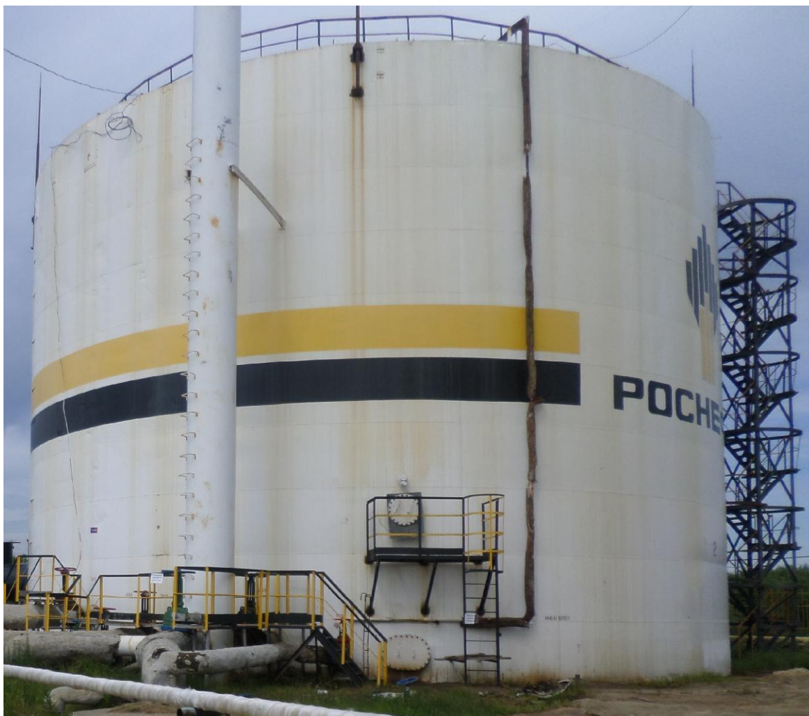
Рисунок 2 - Общий вид резервуара стального вертикального цилиндрического РВС-5000
