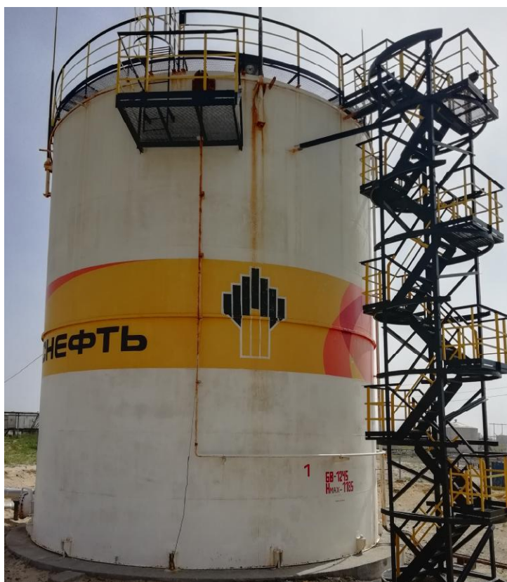
Рисунок 1 - Общий вид резервуара стального вертикального цилиндрического РВС-1000
