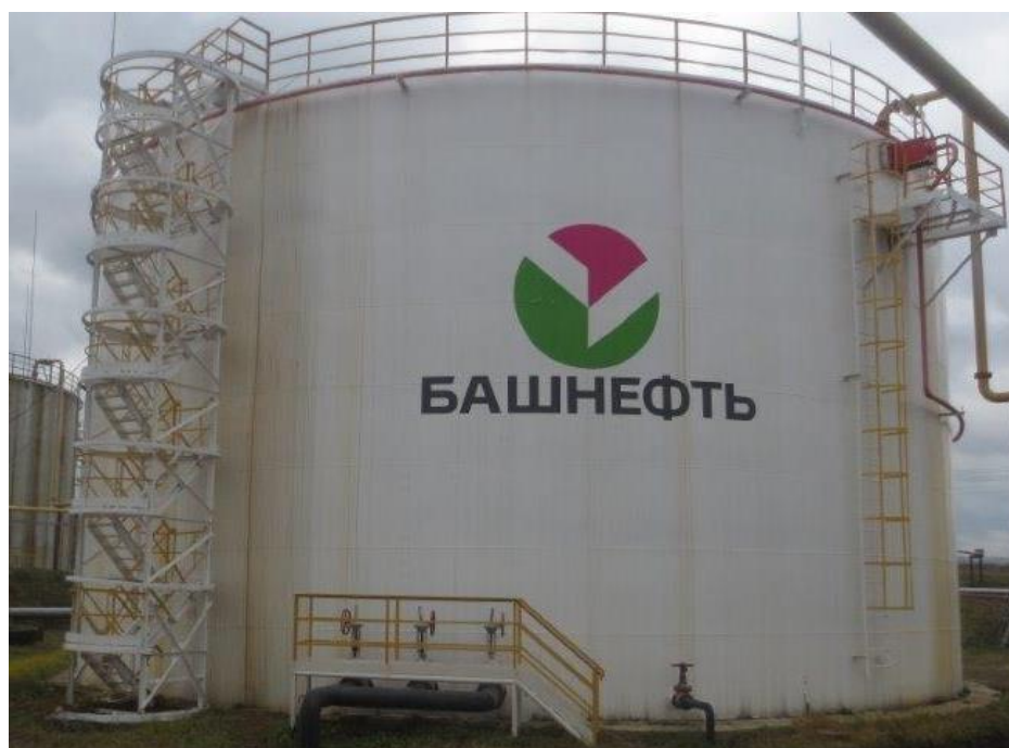
Рисунок 2 - Общий вид резервуара стального вертикального цилиндрического РВС-5000
