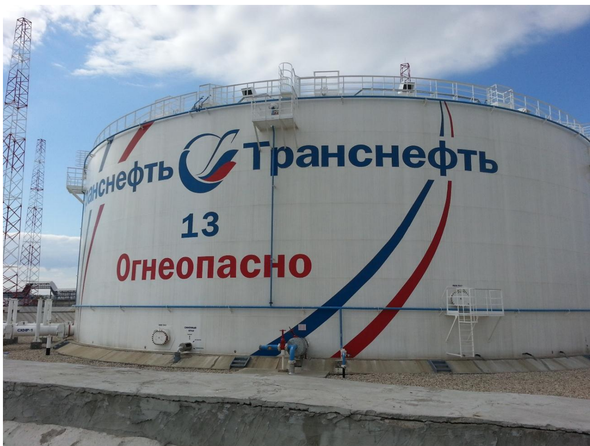
Рисунок 2 - Общий вид резервуара вертикального стального цилиндрического РВСП-20000
