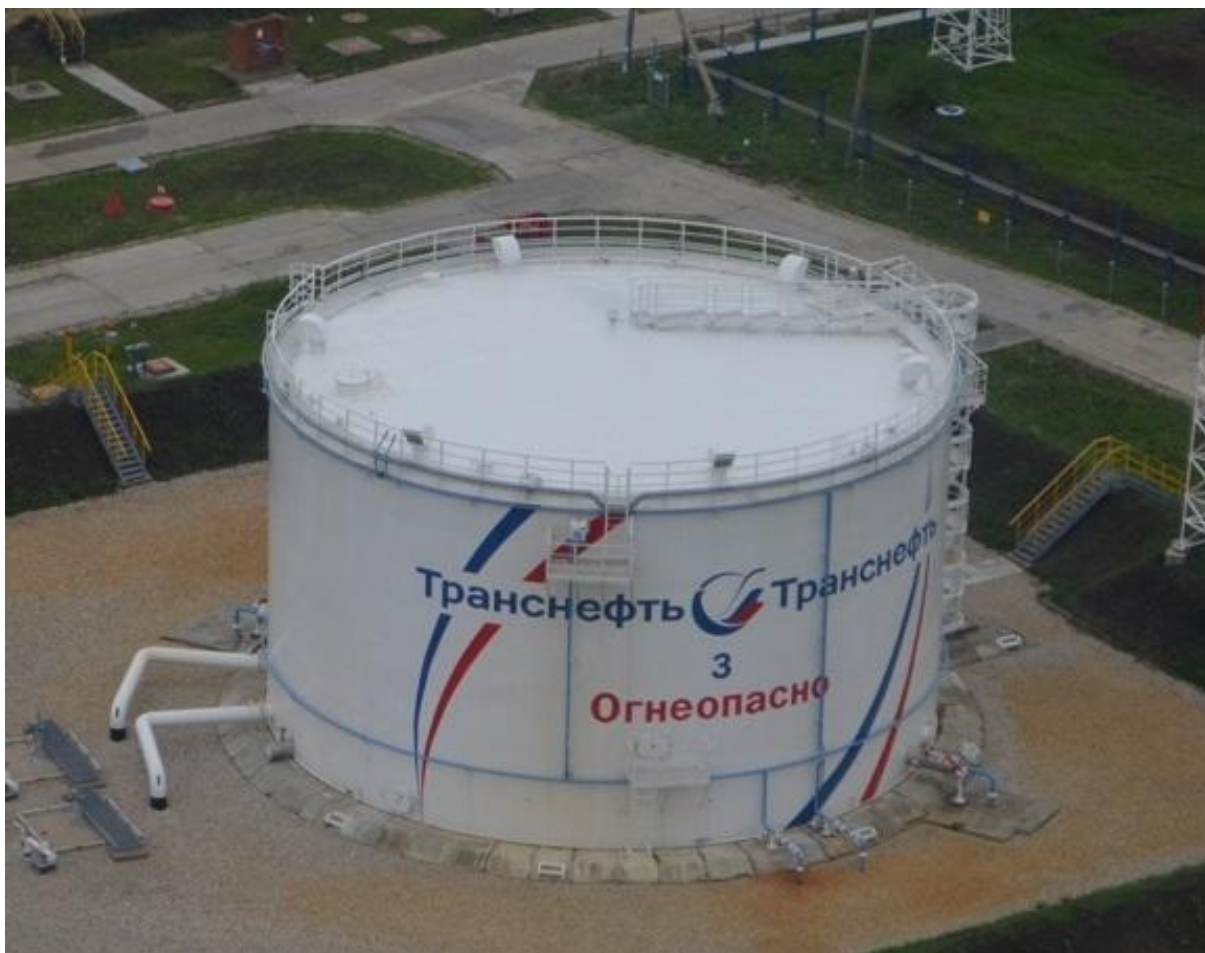
Рисунок 1 - Общий вид резервуара вертикального стального цилиндрического РВСП-5000
