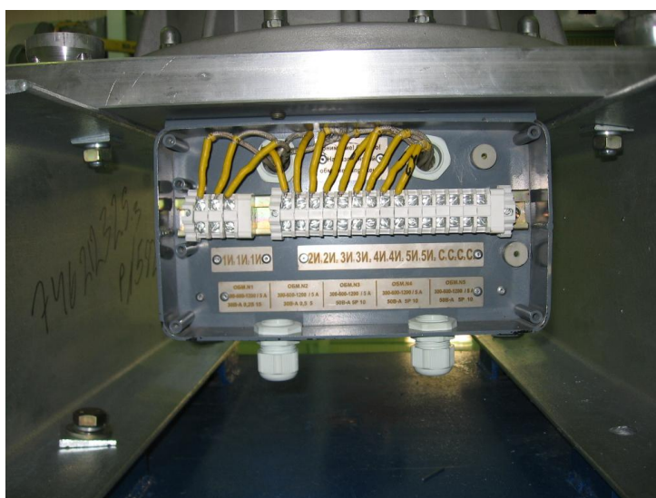
Рисунок 3 - Общий вид клеммной коробки трансформатора
