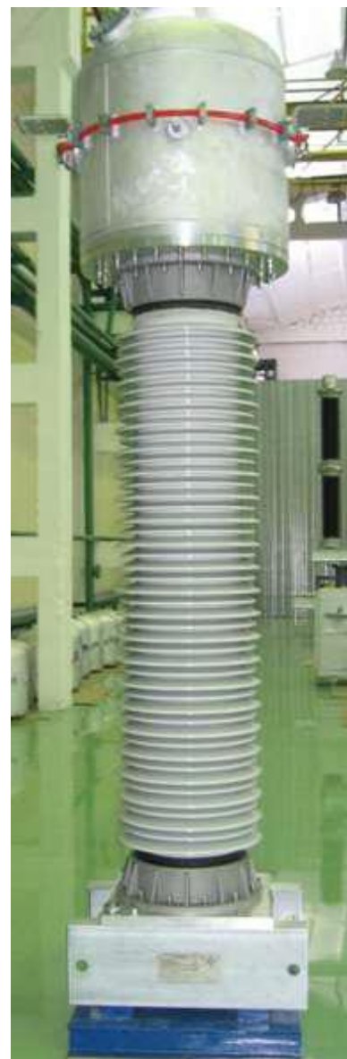
Рисунок 2 - Общий вид трансформатора тока ТОГФМ - 220
