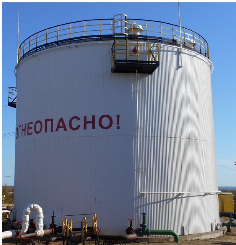
Рисунок 1 - Общий вид резервуара стального вертикального цилиндрического РВС-2000
