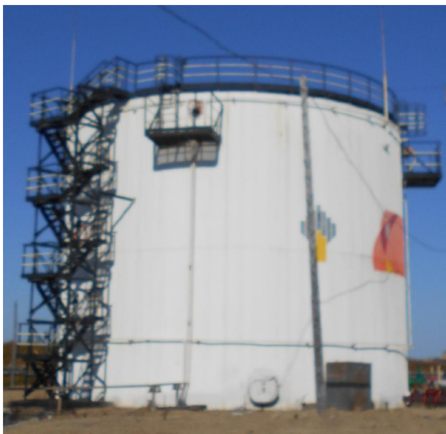
Рисунок 1 - Общий вид резервуара стального вертикального цилиндрического РВС-2000
