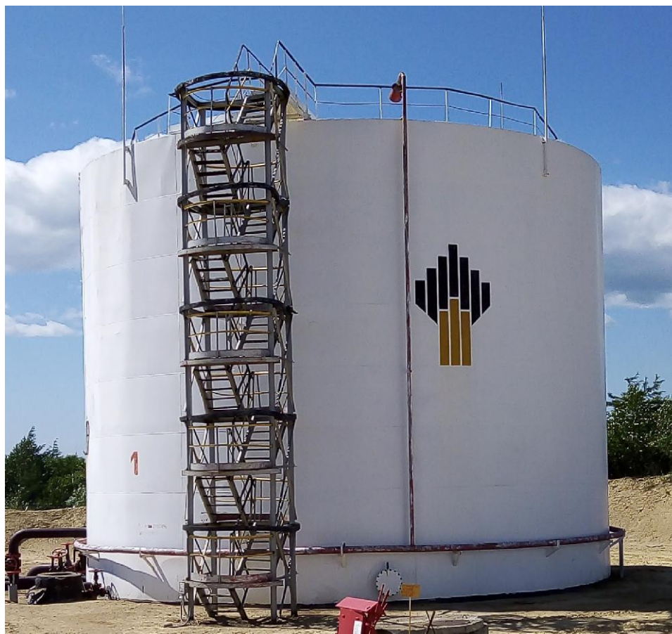
Рисунок 1 - Общий вид резервуара стального вертикального цилиндрического РВС-2000
