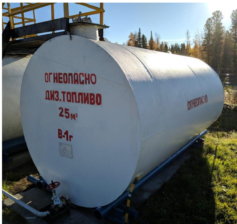
Рисунок 1 - Общий вид резервуаров
