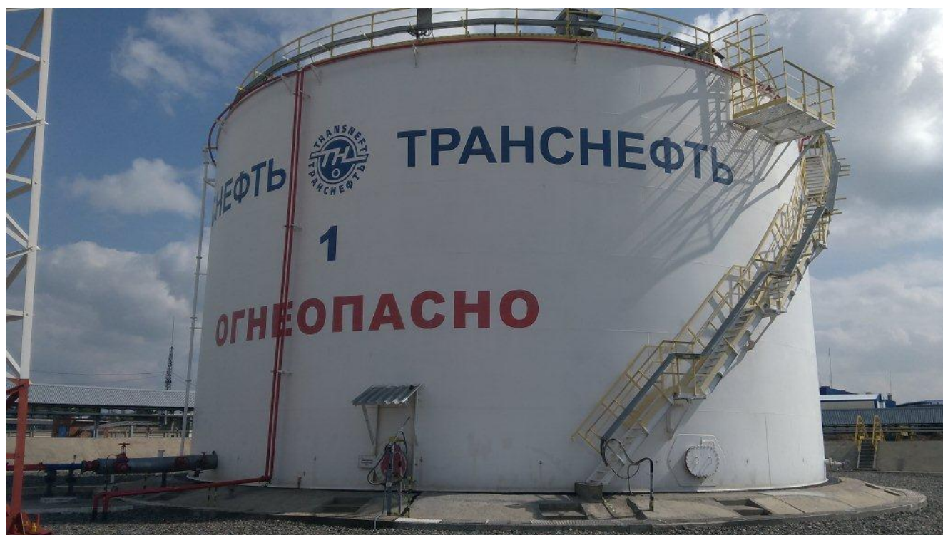
Рисунок 1 - Общий вид резервуара вертикального стального цилиндрического РВС-5000
