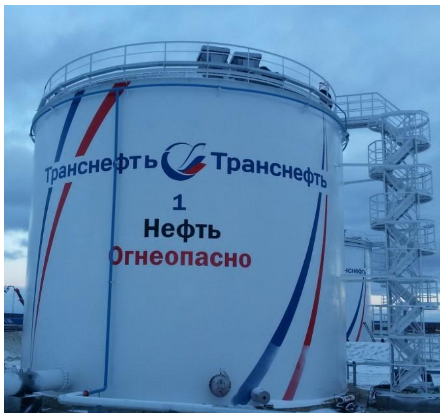
Рисунок 1 - Общий вид резервуаров вертикальных стальных цилиндрических РВС-2000
