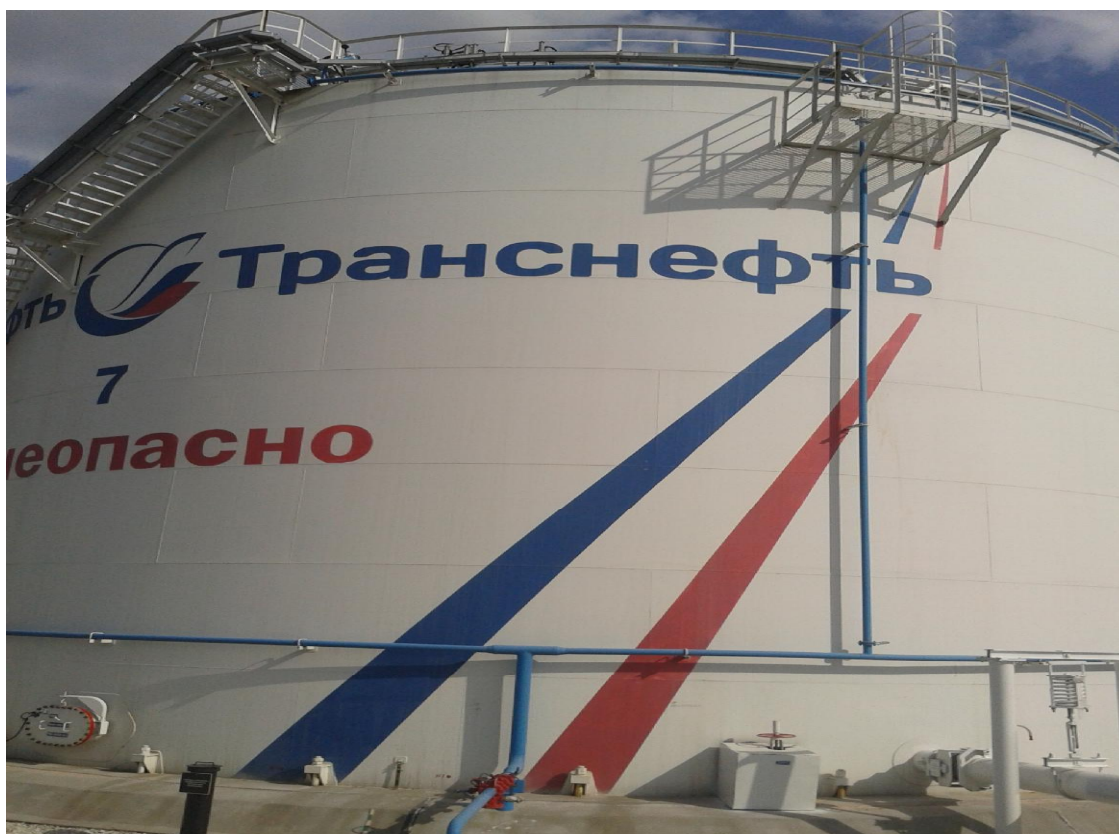
Рисунок 1 - Общий вид резервуара вертикального стального цилиндрического РВСП-5000
