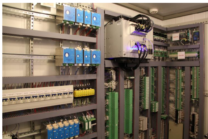
Рисунок 2 – Общий вид БУ САУ ГПА «КВАНТ-Р» исполнения 1 и 3
