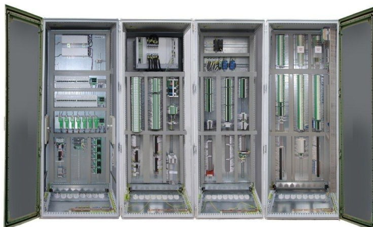
Рисунок 3 – Общий вид БУ САУ ГПА «КВАНТ-Р» исполнения 2 и 4
